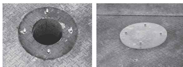
写真-2 カメラを挿入するための点検孔（左：開口時、右：閉口時）
